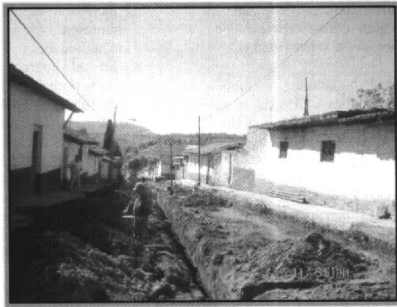
En esta imagen se observa el proceso de rehabilitación de drenajes en las nuevas calles con empedrado Ahogado.
